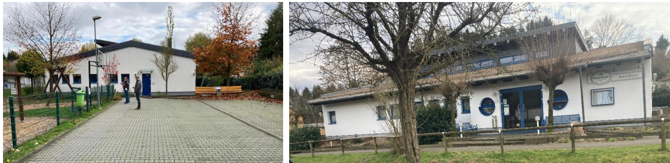
Abb. 46 : Dorfgemeinschaftshaus Streitberg mit Vorplatz
