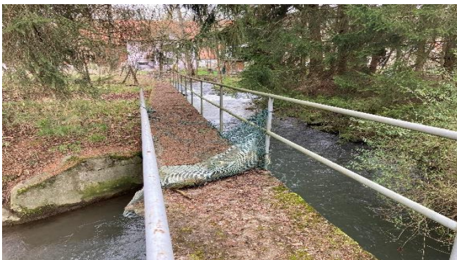
Abb. 31 : Reichenbach mit Fußwegeverbindung und Steg
