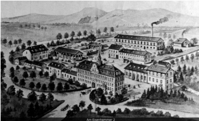
Abb. 11 : Barockes Verwaltungsgebäude des Eisenhammers und Jagdschloss, erbaut v. d. Grafen von Isenburg-Wächtersbach 1723
