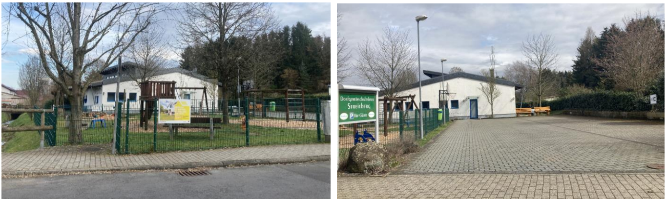
Abb. 37 : Spielplatz und Umfeld am Dorfgemeinschaftshaus in Streitberg
