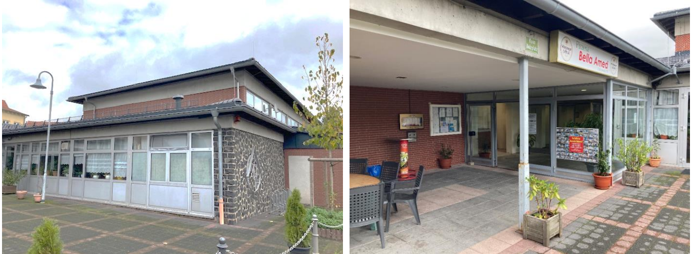
Abb. 43 : Mehrzweckhalle Neuenschmidten | Saalbau und Eingangsbereich
