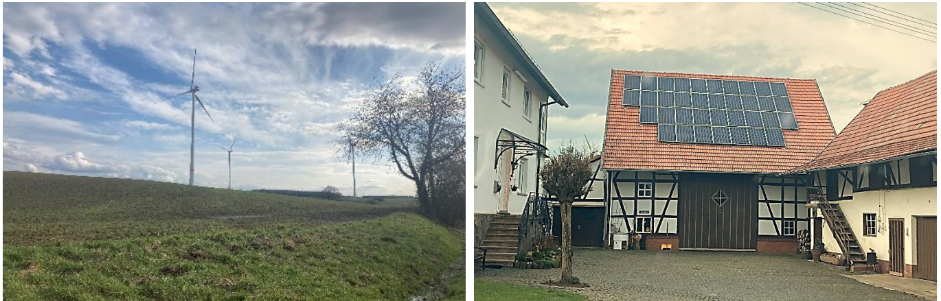
Abb. 61 : Windkraftanlagen auf der Streitberger Platte | PV-Anlage auf einem Scheunendach in Streitberg
