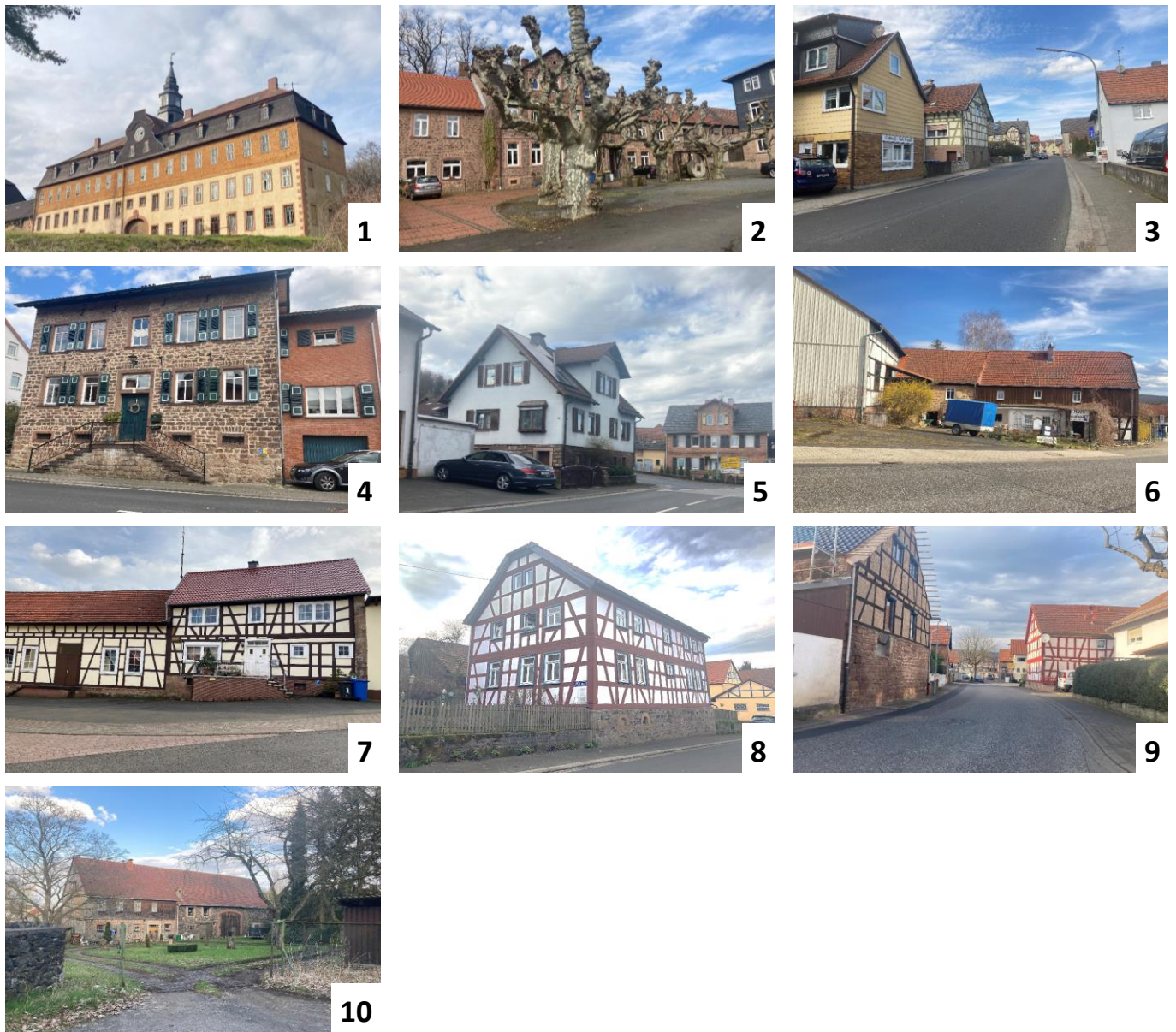
Abb. 22 : Städtebauliche Struktur und historische Bausubstanz
